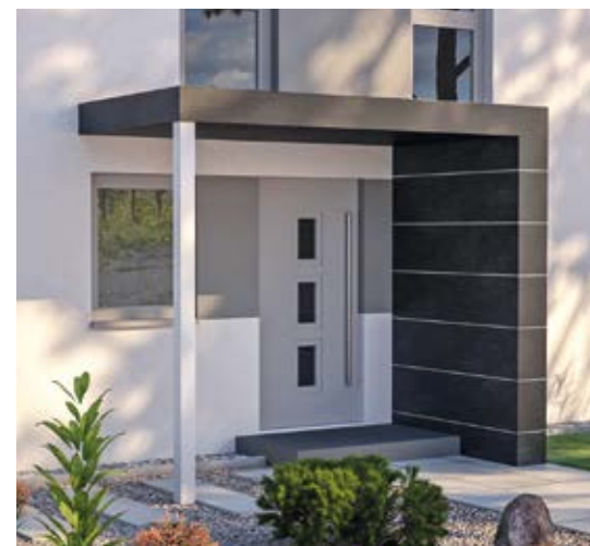
Vordach mit klarer, moderner Form
