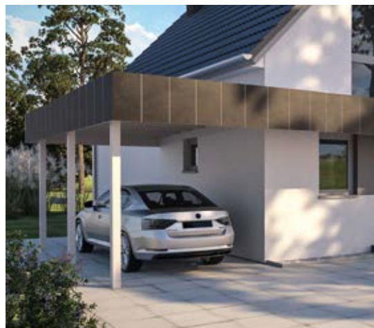
Carport mit Eingangüberdachung
