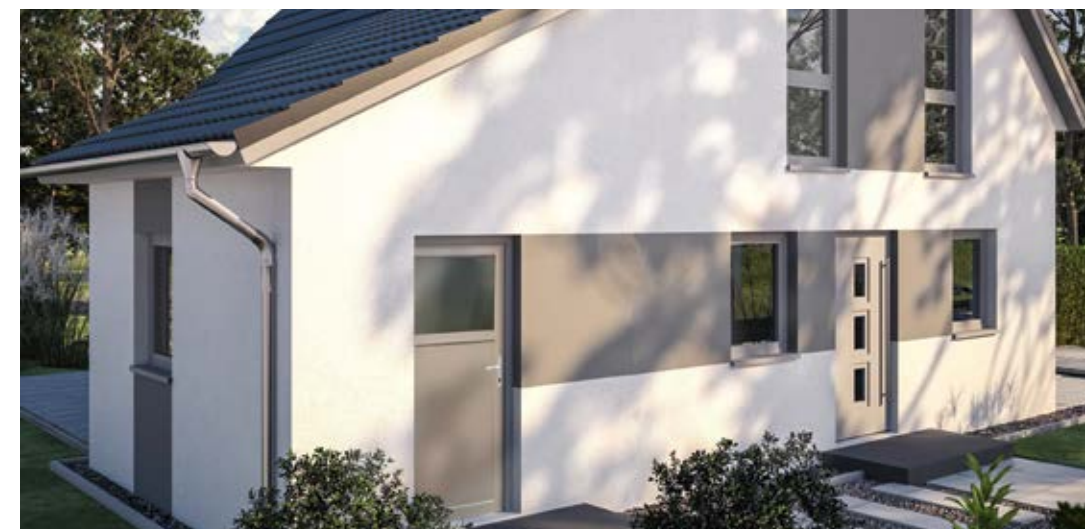
Kellerersatzraum mit Schleppdach
